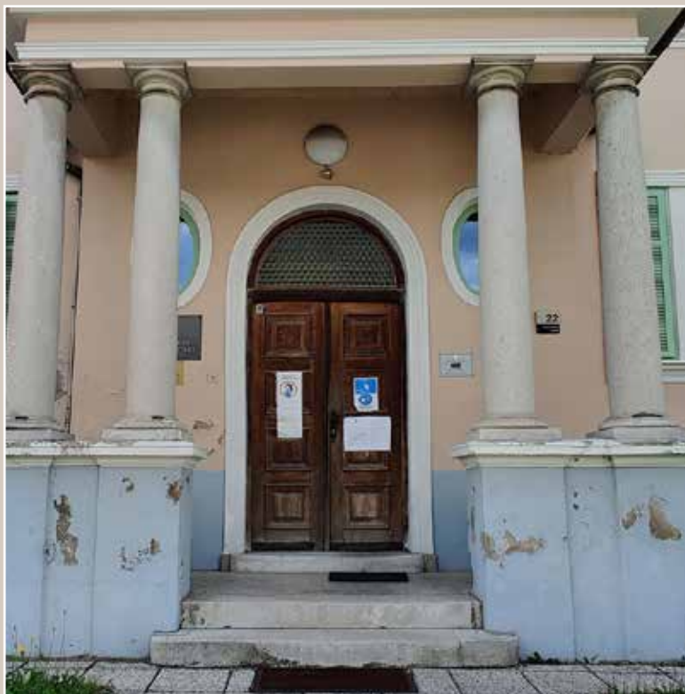
Okrajno sodišče v Ilirski Bistrici (Bazoviška cesta, 22)
