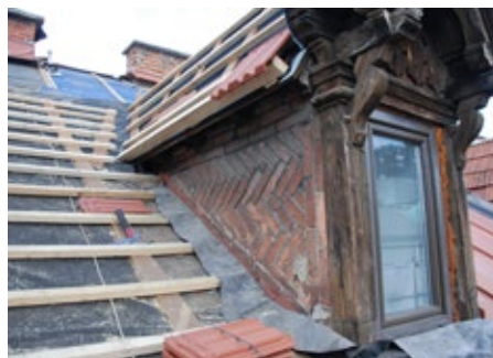
(64) Obnova strehe z izvedbo sekundarne kritine in zračnega kanala.
