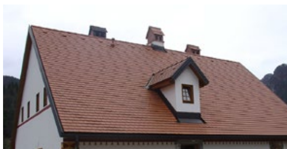
(66) Celovito prenovljena poševna streha spomenika lokalnega pomena (Hiša Gorenja Trebuša 37, EŠD: 5044).
