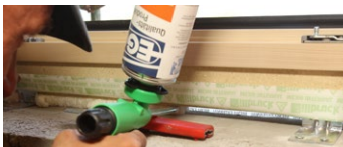
(85) Tesnjenje srednje ravni vgradne rege pred lepljenjem zunanega in notranjega tesnilnega traku na zidno konstrukcijo.
