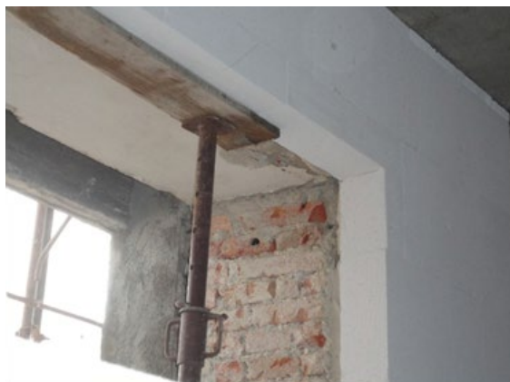
(48) Vgradnja kapilarno aktivne toplotne zaščite na notranjo stran zunanje stene.
