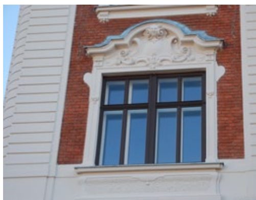
(82) Posodobljeno okno z odpiranjem navznoter.
