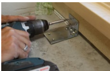
(84) Podpiranje, niveliranje in mehanska pritrditev okna.
