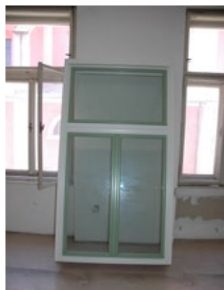
(80) Pri menjavi večjega števila oken je priporočljivo najprej izdelati vzorčno okno z vsemi detajli.
