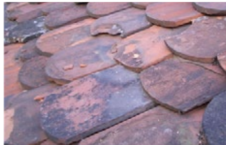
(63) Zamenjava dotrajane strešne kritine je priložnost za izvedbo sekundarne kritine in toplotne zaščite v skladu s sodobnimi pravili stroke.
