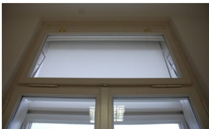
(77) Primer zamenjave notranjih kril z novimi z večslojno zasteklitvijo kot kopija prvotnih. Zunanje krilo s podbojem je obnovljeno.
