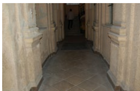
(59) Talne obloge: raznobarvne ploščice, kamniti tlak.
