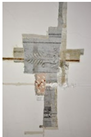
(47) Zazidani stebri s šablonsko poslikavo, prvotne odprtine in poslikave, najdene s sondažnimi raziskavami.
