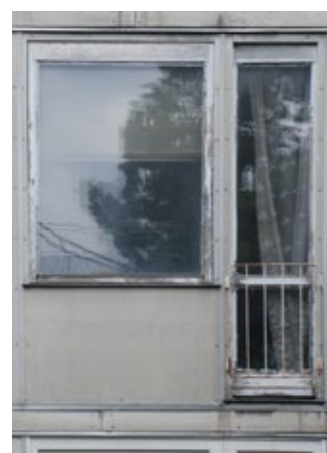
(74) Kovinska okna, značilna za industrijsko arhitekturo, in različne oblike zasteklitve stavb, zgrajenih v drugi polovici 20. stoletja.
