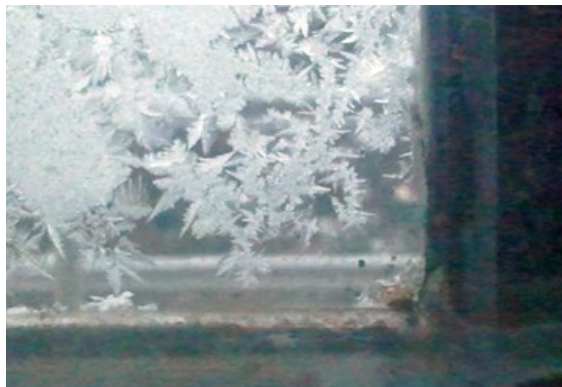
(8) Ledene rože na okenski šipi zaradi zamrznitve kondenzata pri zelo nizkih zunanjih temperaturah.
