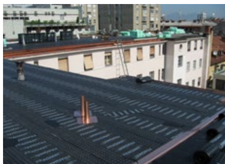
(68) Hidroizolacija ravne strehe z bitumenskimi varilnimi trakovi.
