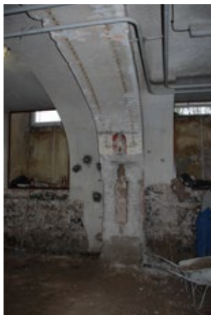
(47) Zazidani stebri s šablonsko poslikavo, prvotne odprtine in poslikave, najdene s sondažnimi raziskavami.
