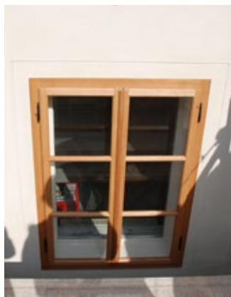
(78) Primer zamenjave notranjih kril z novimi. Zunanja krila so kopije prvotnih, notranja pa nova enojna s sodobno dvojno zasteklitvijo.
