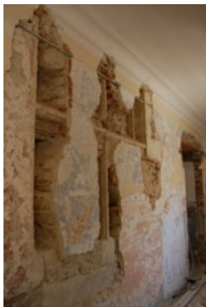
(47) Zazidani stebri s šablonsko poslikavo, prvotne odprtine in poslikave, najdene s sondažnimi raziskavami.
