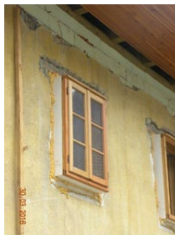
(46) S pomikom stavbnega pohištva iz prvotne ravnine fasade za debelino toplotne izolacije lahko ohranimo razmerja na fasadi.
