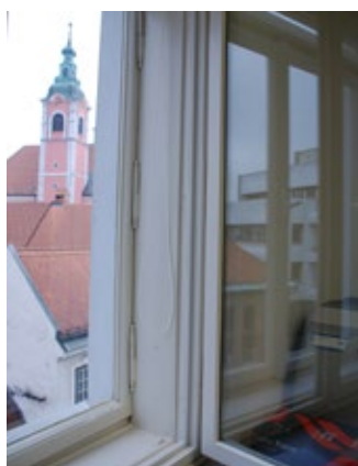
(77) Primer zamenjave notranjih kril z novimi z večslojno zasteklitvijo kot kopija prvotnih. Zunanje krilo s podbojem je obnovljeno.
