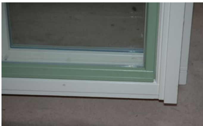
(80) Pri menjavi večjega števila oken je priporočljivo najprej izdelati vzorčno okno z vsemi detajli.
