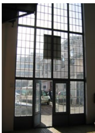
(74) Kovinska okna, značilna za industrijsko arhitekturo, in različne oblike zasteklitve stavb, zgrajenih v drugi polovici 20. stoletja.
