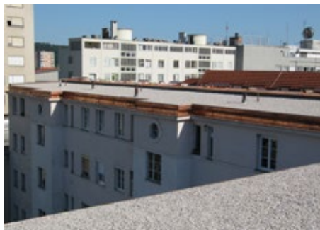
(70) Ravna streha s poustvarjenim zaključnim slojem (prodec).
