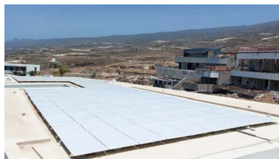
(73, 74) Namestitev FN-modulov na ravni strehi, ki je prilagojena višini atike in ustrezno odmaknjena od roba strehe (vir: BISOL, https://dl.bisol.com/files/Spectrum%20Brochure/BISOL_Spectrum_Brochure_SL.pdf )
