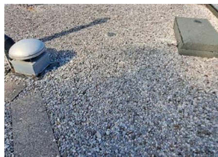
(92) Ravna streha z bitumensko hidroizolacijo in nasutjem (foto: T. Škerlep)
