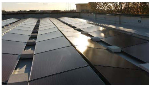
(73, 74) Namestitev FN-modulov na ravni strehi, ki je prilagojena višini atike in ustrezno odmaknjena od roba strehe (vir: BISOL, https://dl.bisol.com/files/Spectrum%20Brochure/BISOL_Spectrum_Brochure_SL.pdf )
