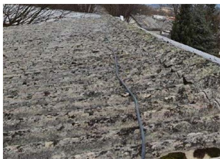
(91) Kritina iz azbestno-cementnih plošč, ki ni primerna z okoljskega in zdravstvenega vidika (foto: S. Gostič)
