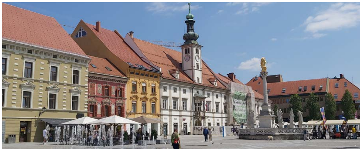
(93) Primer požarnih sektorjev na glavnem trgu v Mariboru, ločenih s požarnimi zidovi nad strešinami. Postavitev FN-naprave na strehi, nad katero je okenska odprtina, s stališča požarne varnosti ni dopustna, saj poveča požarno tveganje (foto: N. Jejčič).
