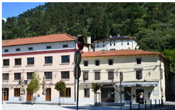
(8) Negativen vidni vpliv na glavni javni prostor naselja. FN-naprava je nameščena na izjemno izpostavljeno streho objekta na pobočju za glavnim trgom v naselju, ki je zavarovano kot spomenik (foto: D. Gantar).
