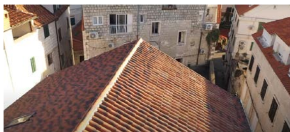
(84, 85) Strešnik integriranega fotonapetostnega sistema Dyaqua, uporabljen na strehi gledališča v mestnem jedru Splita (vir: Dyaqua)
