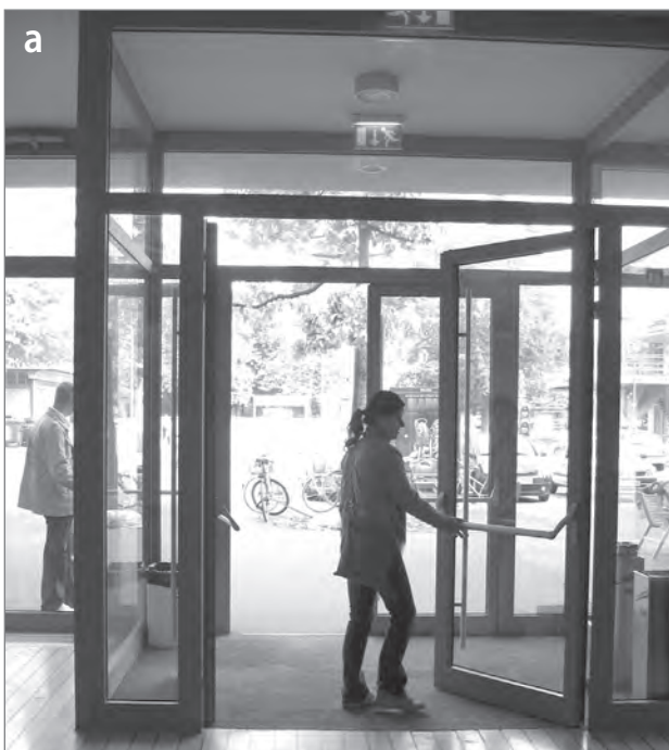
Slika 10: (a) Primer dovolj prostornega vetrolova; (b) primer zelo ozkega vhoda v objekt, ki je brez vetrolova (starejši objekt, ki ne dopušča večjega vetrolova).
