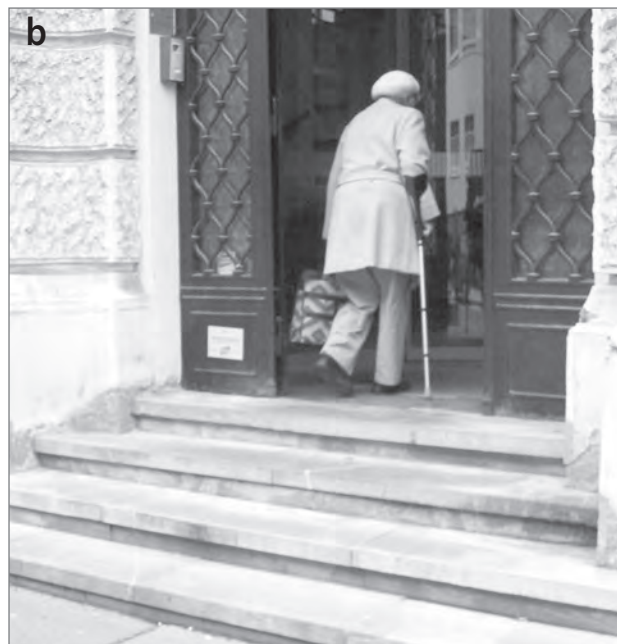
Slika 6: (a) Nedostopen glavni vhod zaradi samo ene stopnice; (b) stopnišče glavnega vhoda brez oprijemal za varnejši vstop in brez informacije o dostopnem stranskemu vhodu za osebe na invalidskem vozičku
