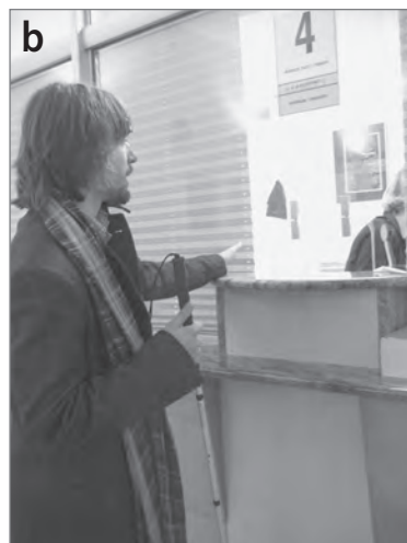
Slika 16: (a) Ob robu hodnika konzolno nameščen aparat za razvrstilne listke pomeni oviro na poti pri gibanju slepe osebe, manj primerna je tudi nameščenost, ki od sedečega zahteva dodaten napor; (b) neprimeren pult za poslovanje s strankami – njegovo polno pročelje onemogoča približanje, njegova višina pa komunikacijo; (c) primer primerne višine pulta za poslovanje s strankami, tudi pročelje pulta je vsaj delno umaknjeno v notranjost, kar osebi na invalidskem vozičku omogoča večje približanje.
