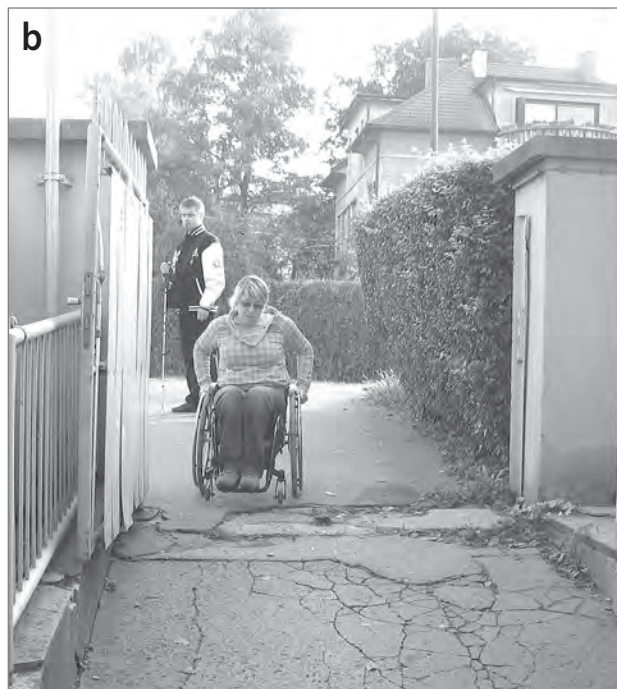
Slika 5: (a) Kljub blagemu nagibu je nujno potrebno, da je klančina vsakih 6 m prekinjena z 1,5 m dolgim podestom, le tako jo povprečni uporabnik na vozičku lahko samostojno uporabi; (b) nevdrževana klančina na dostopni poti.
