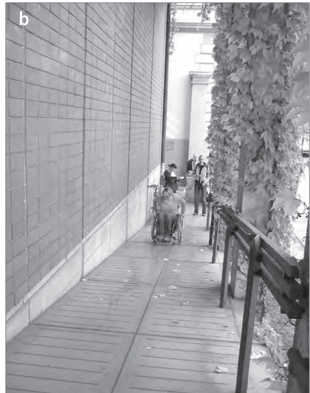
Slika 7: (a) Dostopen stranski vhod za osebe na invalidskih vozičkih z urejeno klančino; (b) dolžina, naklon, vmesni podest in določila za ograjo pri klančini morajo biti v skladu z zakonodajnim okvirom, po katerem mora biti klančina primerna za samostojno uporabo oseb na invalidskem vozičku. Na sliki je primer, v katerem določila niso upoštevana.
