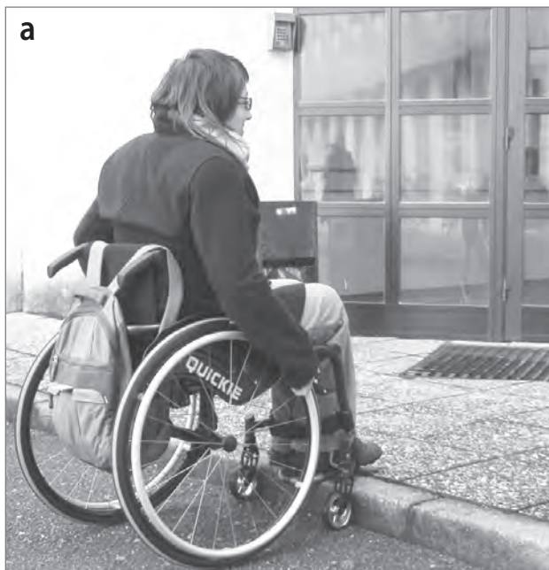
Slika 6: (a) Nedostopen glavni vhod zaradi samo ene stopnice; (b) stopnišče glavnega vhoda brez oprijemal za varnejši vstop in brez informacije o dostopnem stranskemu vhodu za osebe na invalidskem vozičku
