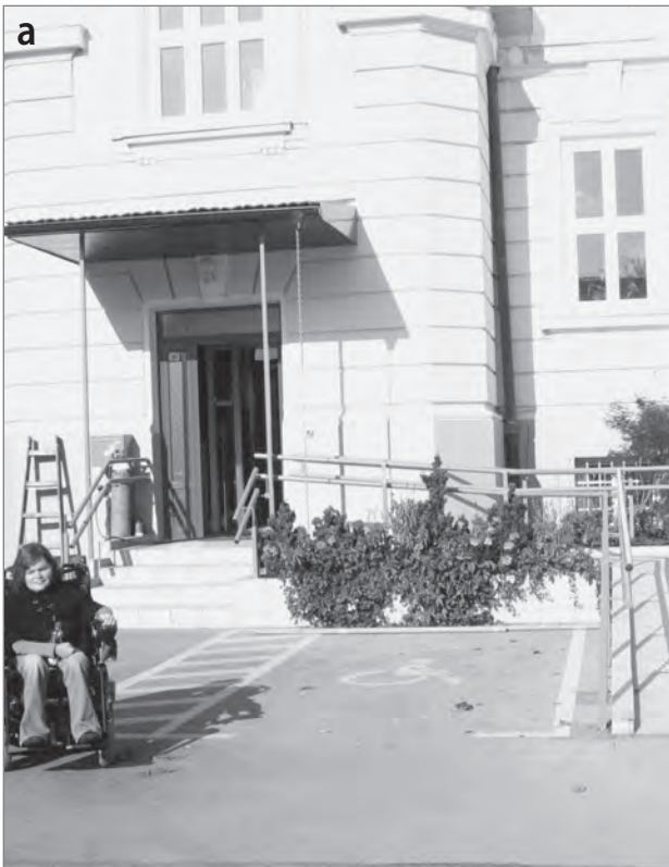
Slika 7: (a) Dostopen stranski vhod za osebe na invalidskih vozičkih z urejeno klančino; (b) dolžina, naklon, vmesni podest in določila za ograjo pri klančini morajo biti v skladu z zakonodajnim okvirom, po katerem mora biti klančina primerna za samostojno uporabo oseb na invalidskem vozičku. Na sliki je primer, v katerem določila niso upoštevana.
