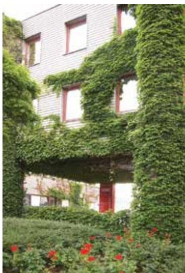
Slika 3.1: Zelena fasada z vzpenjavkami, ki izraščajo iz tal in ne potrebujejo opore (fotografija: Irene Zluwa)
