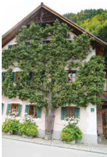
Slika 3.1: Zelena fasada z vzpenjavkami, ki izraščajo iz tal in ne potrebujejo opore (fotografija: Irene Zluwa)
