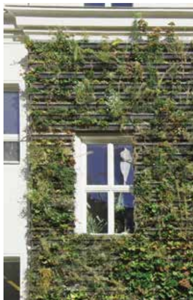
Slika 3.5: Živa stena s sistemom uporabe sadilnih posod na nosilni konstrukciji z oporo (levo, fotografija: Irene Zluwa)
