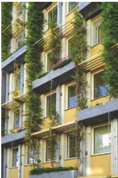
Slika 3.5: Živa stena s sistemom uporabe sadilnih posod na nosilni konstrukciji z oporo (levo, fotografija: Irene Zluwa)
